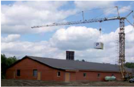
Komplettstall in Emsdetten
