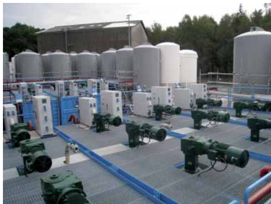
Betonpumpanlage Atomversuchsreaktor Jülich
