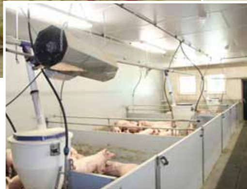
Heizgebläse für Erd- und Flüssiggas mit einer Leistung von bis zu 75 kW.
