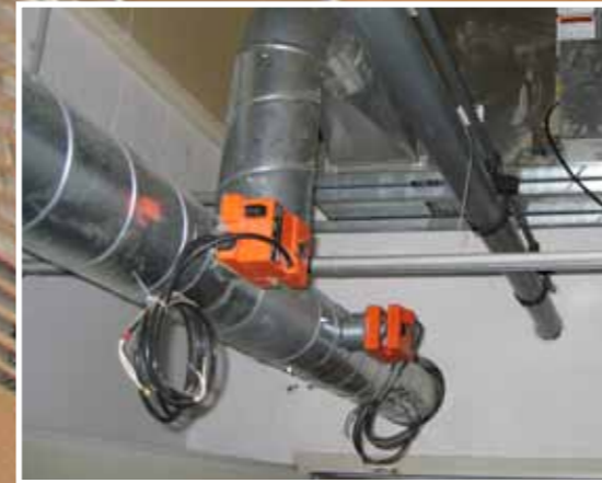
Luftverteilung über Drosselklappen mit Stellmotor
