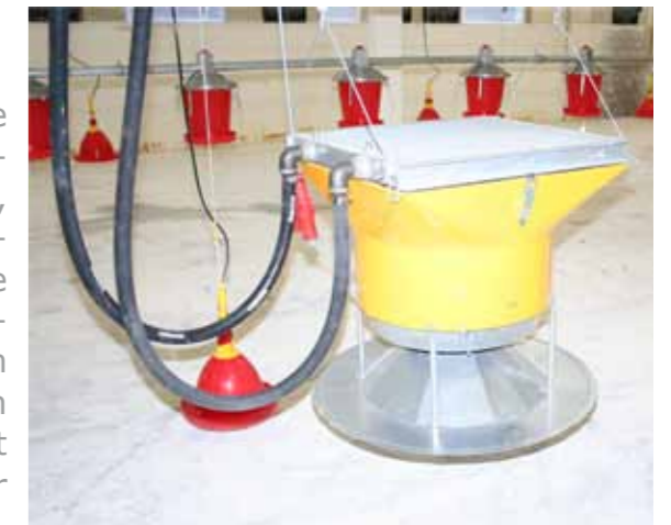
Im Putenaufzuchtstall installierter PS-Warmwasserkonvektor.
