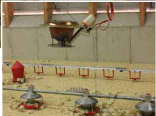
Gasstrahler für Erd- und Flüssiggas bis zu einer Leistung von 8000 Watt.
