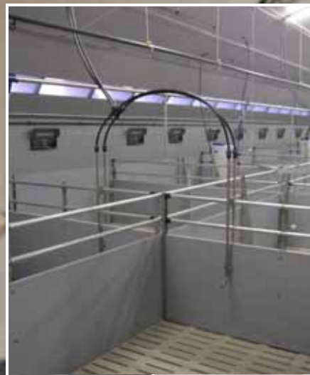
Wandventil AIV54 als Zuluftventil im Schweinemaststall
