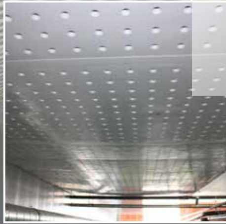
Rieselkanal über dem Tierbereich
