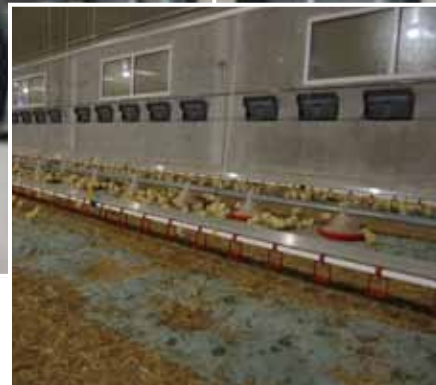
Wandventil AIV54 als Zuluftventil im Hähnchenstall
