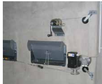
Wandventil AIV54 mit Öffnungssystem
