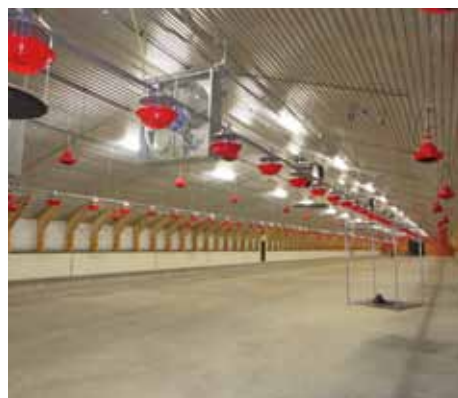
Zur Entmistung werden die Feed Master Futterlinien unter die Decke gefahren.
