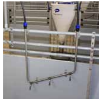
Nippelstandrohr für drei Nippeltränken
