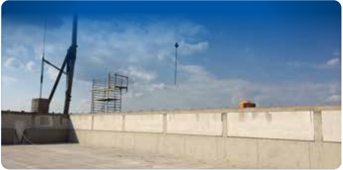
Betonaufkantung mit Kalksandstein
