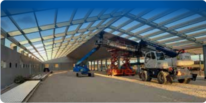
Stahlhalle mit Betonelemente
