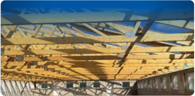
Dachkonstruktion mit Holzbinder
