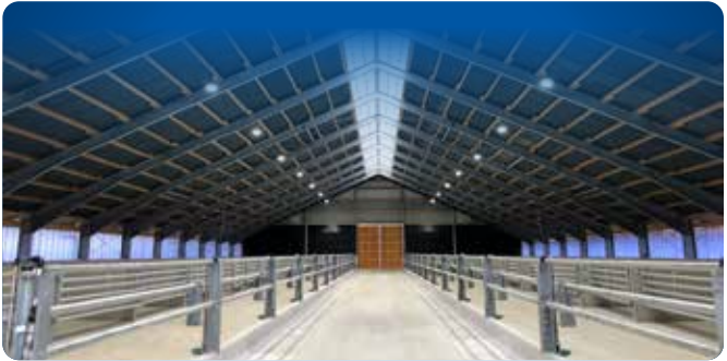
Bullenmaststall mit Stahlkonstruktion
